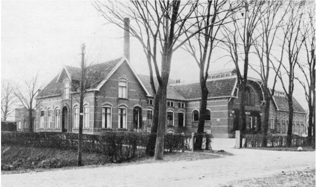
Coöperatieve Zuivelfabriek te Luinjeberd
