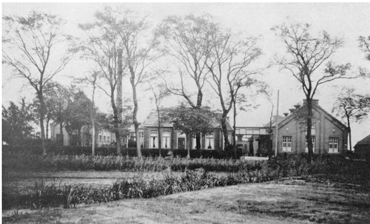
Coöperatieve Zuivelfabriek te Giekerk
