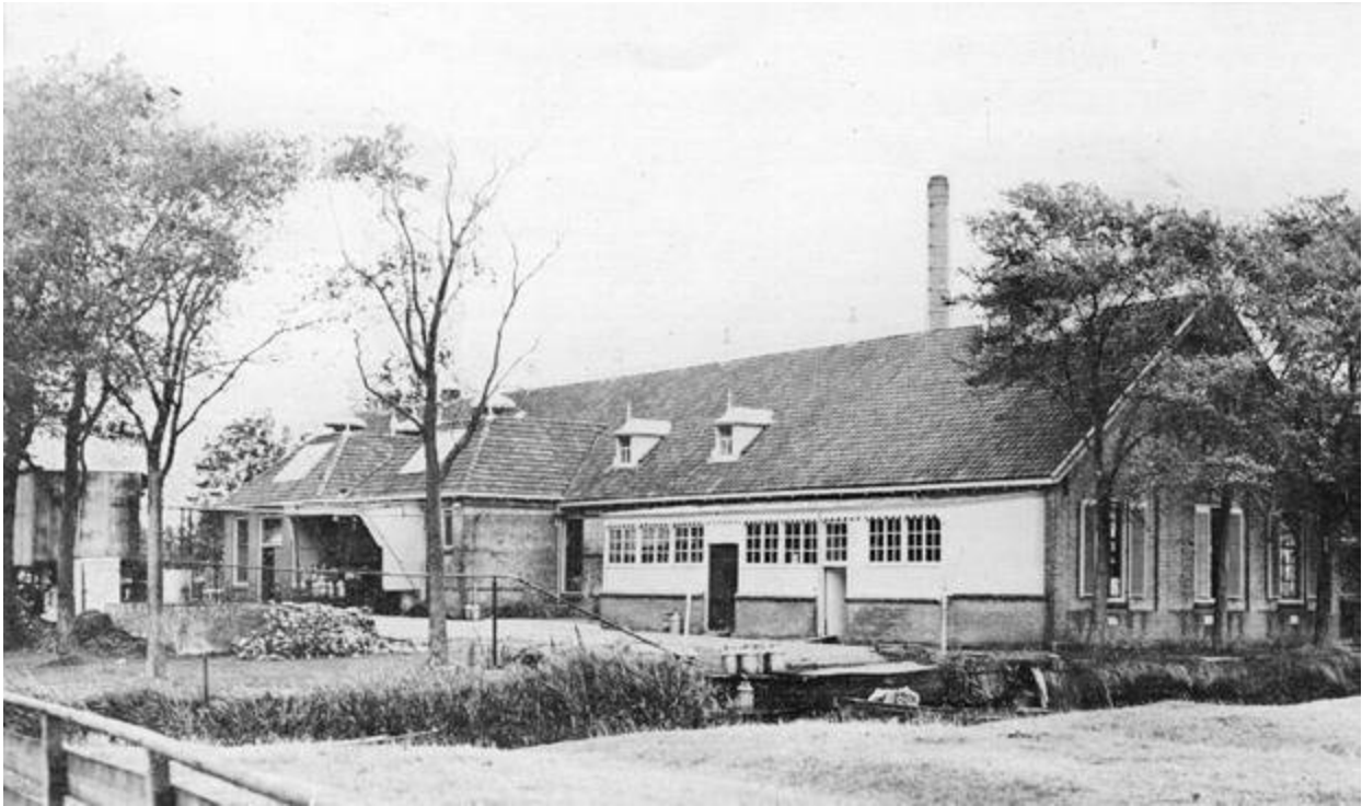
Coöperatieve Zuivelfabriek te Winsum
