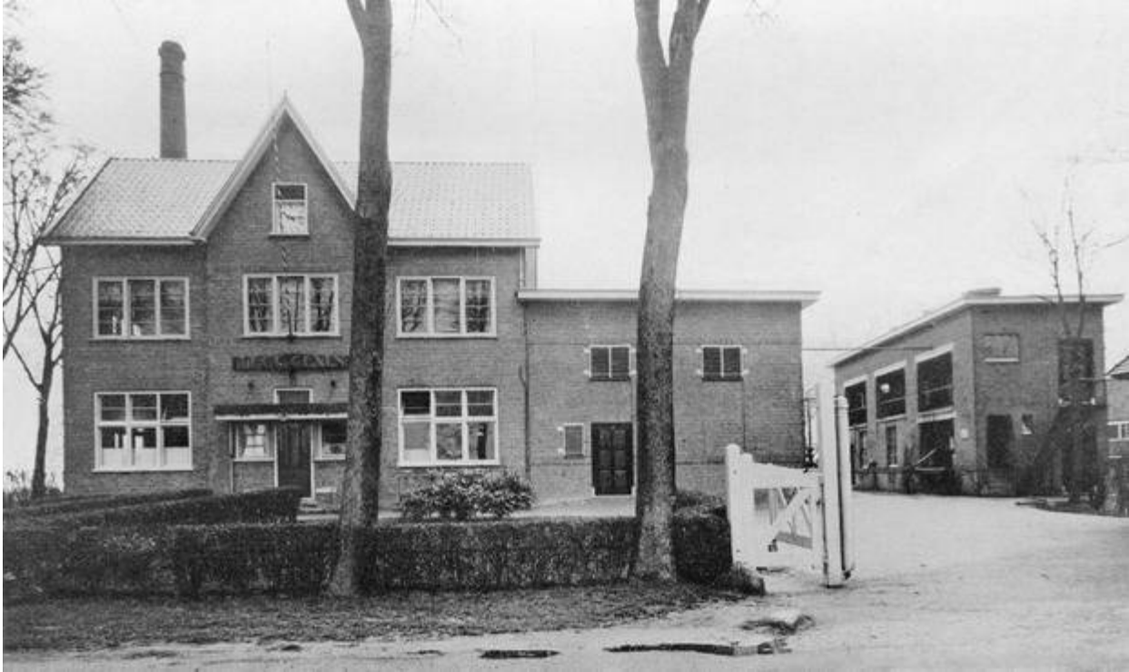
Coöperatieve Zuivelfabriek te Sijbrandaburen
