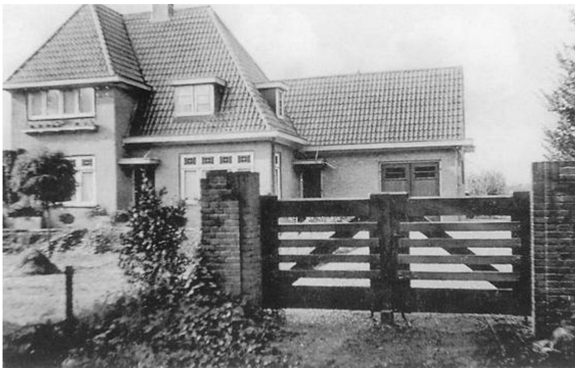
De directeurswoning, Aelderstraat 17, Aalden
