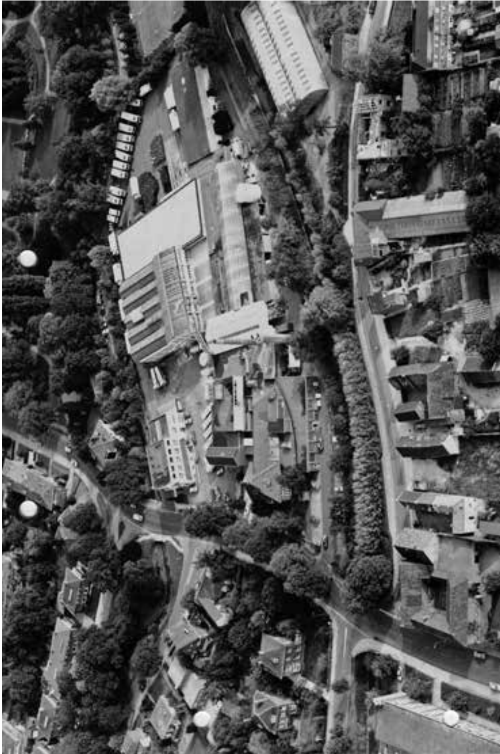
Luchtfoto fabriekcomplex Sittard.
