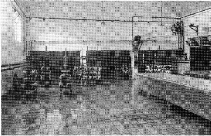
Rechts de stopbakken, waarin de kaasvaten werden gevuld en verder kaaspersen (1928)
