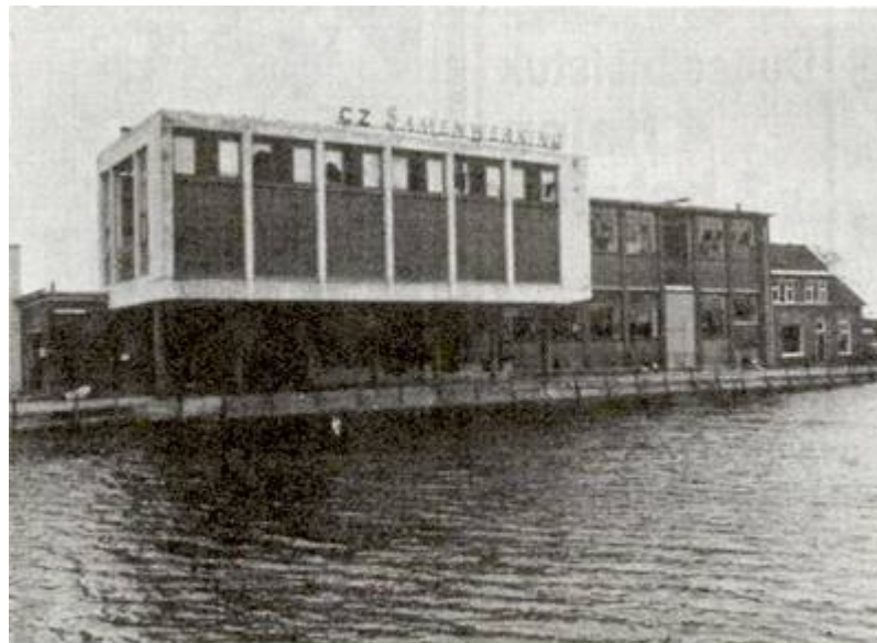
De verwaarloosde en verlaten melkfabriek. (Foto Marcel Köppen).
