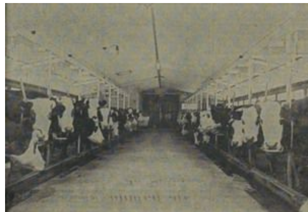
Het interieur van de veestal met links en rechts langs de grond de melkbuisen.
