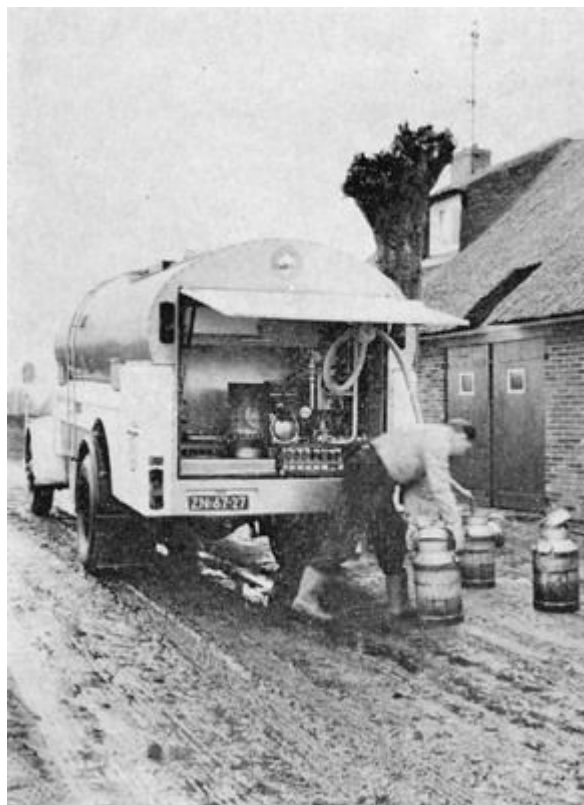
DDMM RMO met bussenspoelvoorziening Bron: OO Machevo 1971-10-11 nr.
