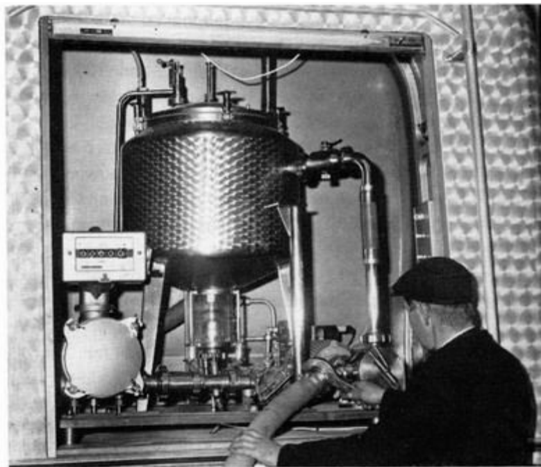
Een belangrijk punt bij de RMO is het meten van de hoeveelheid melk die door de boer geleverd wordt.
