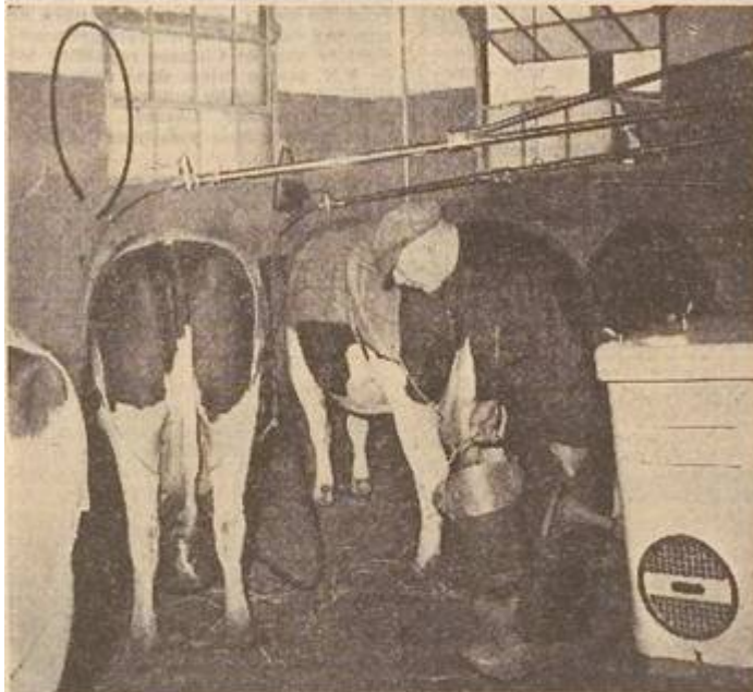
De uitvinder, boer Bajema, tussen zijn beesten, met rechts de door hem uit- gevonden melkmachine. De korte vacuum-leiding is boven de dieren zichtbaar.
