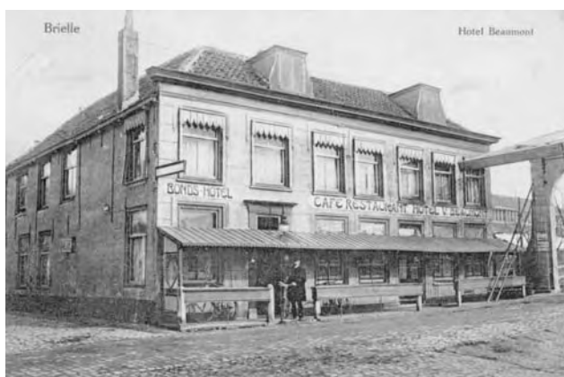
Hotel Verwoerd werd enige jaren later hotel Tekke en weer later Van Beaumont. Uiterlijk zal het gebouw er in 1879 niet veel anders hebben uitgezien als op deze foto uit ca. 1910.
