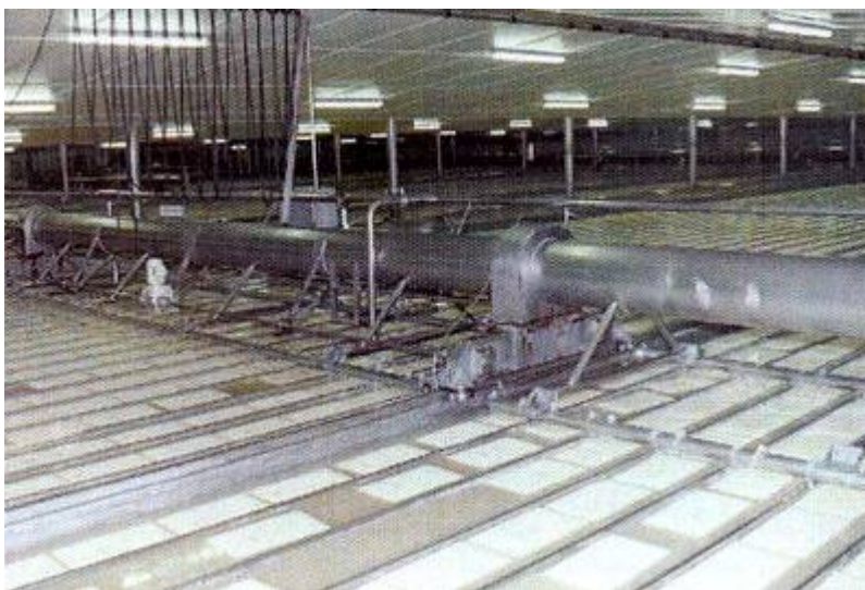
Het pekelbassin in Dronrijp.
