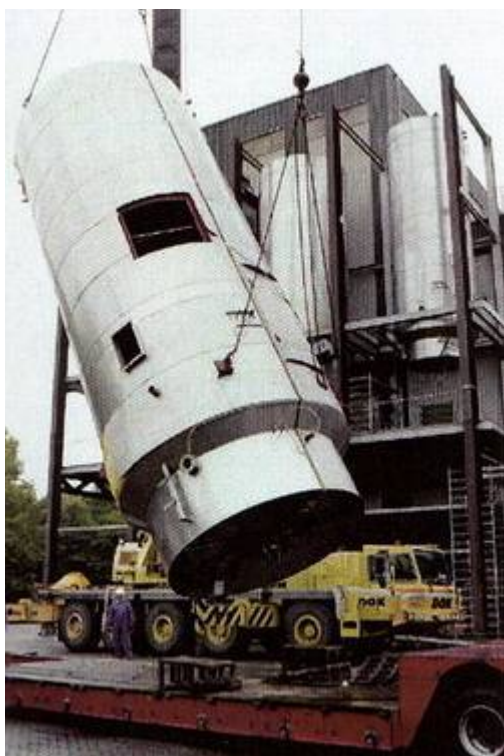
Bouw filterpoederkast.
