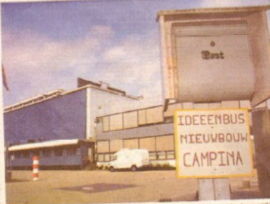
De Melkunie Maasdam heeft een ideebus voor de nieuwbouw van de fabriek. Volgens de huidige plannen wordt het gebouw 21 meter hoog over een breedte van honderd meter, tot achter van de politiek in Maasdam, een heel andere
