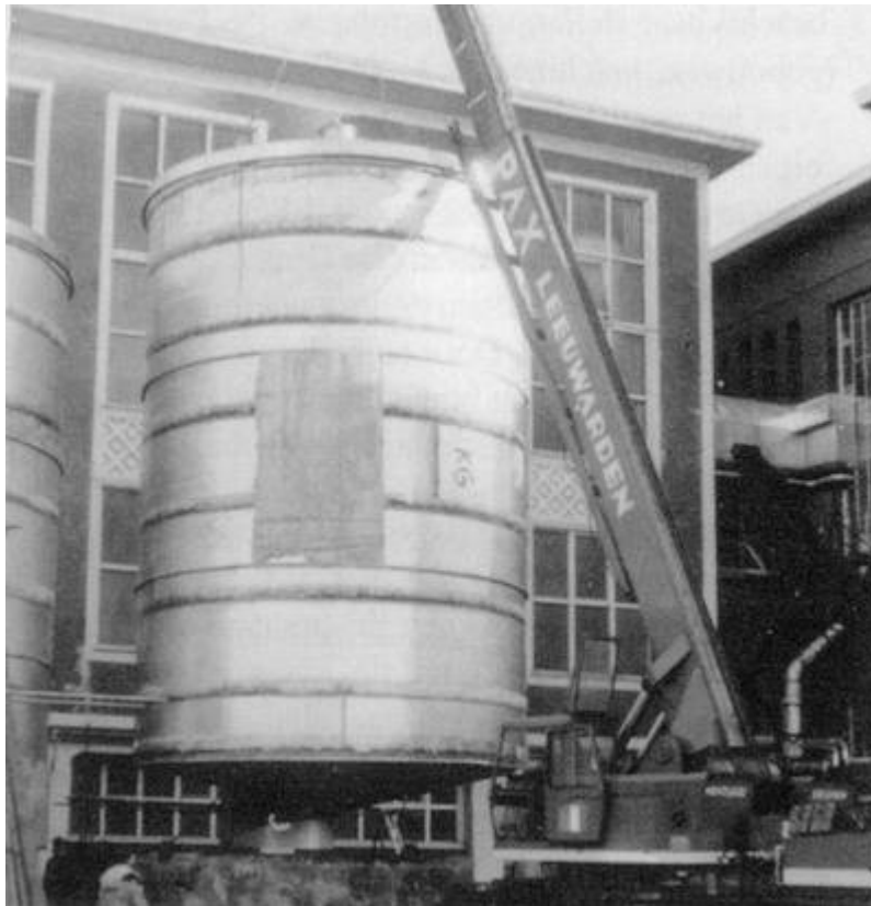
Plaatsen van 200 tons opslagtank.
