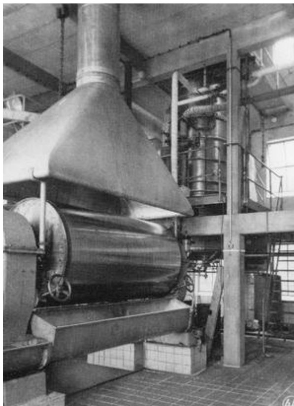
De drooginstallatie (éénwalsensysteem).
