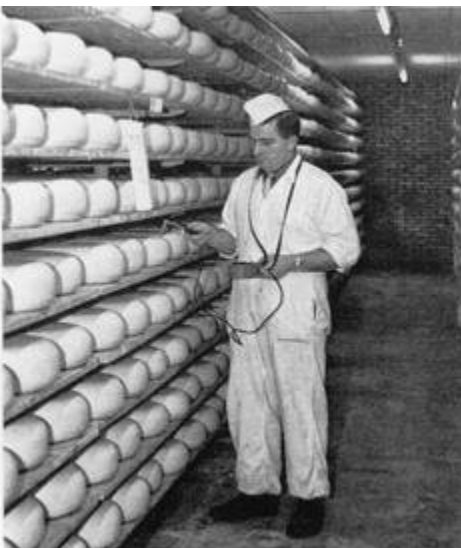
Metingen van de relatieve vochtigheid en van de lucht- snelheid in het kaaspakhuis (H. Wardenier).
