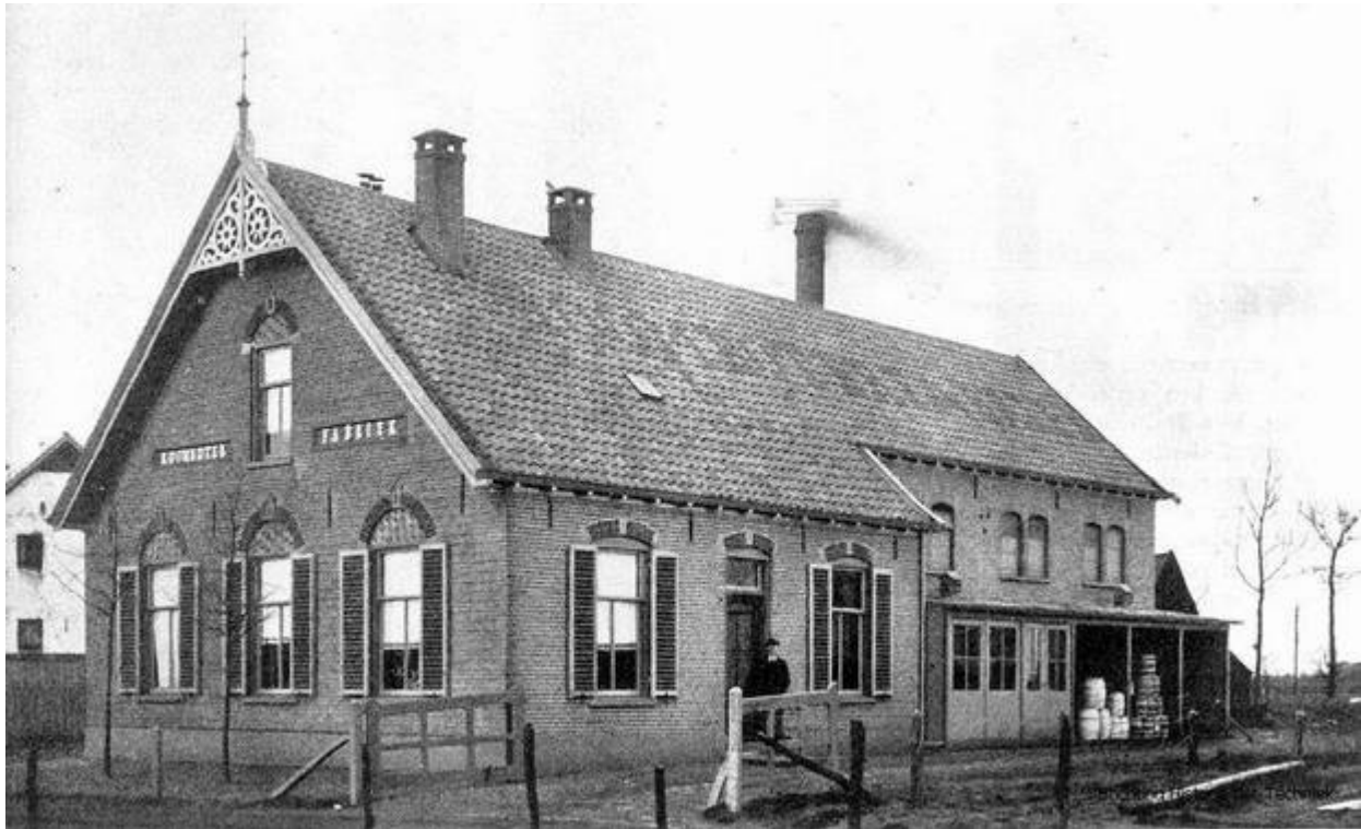
Opname van de 'Roomboterfabriek' te Didam.
