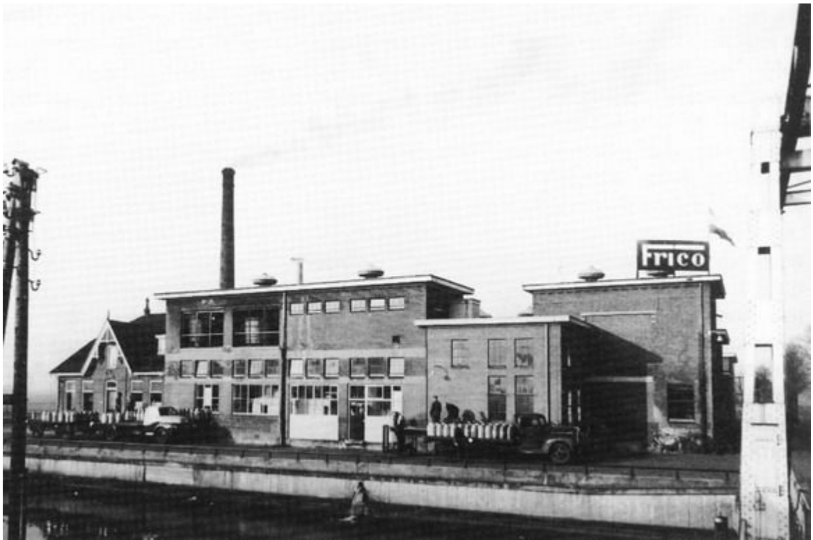
De fabriek in Terwispel in latere jaren Nog steeds is links op de foto een deel van de oorspronkelijke fabriek te zien.
