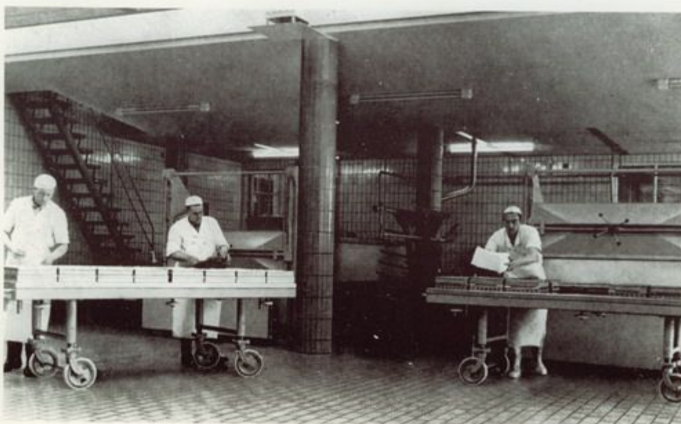
De machinaal gevormde wongel- blokken worden geplaatst in de kaasvaten
