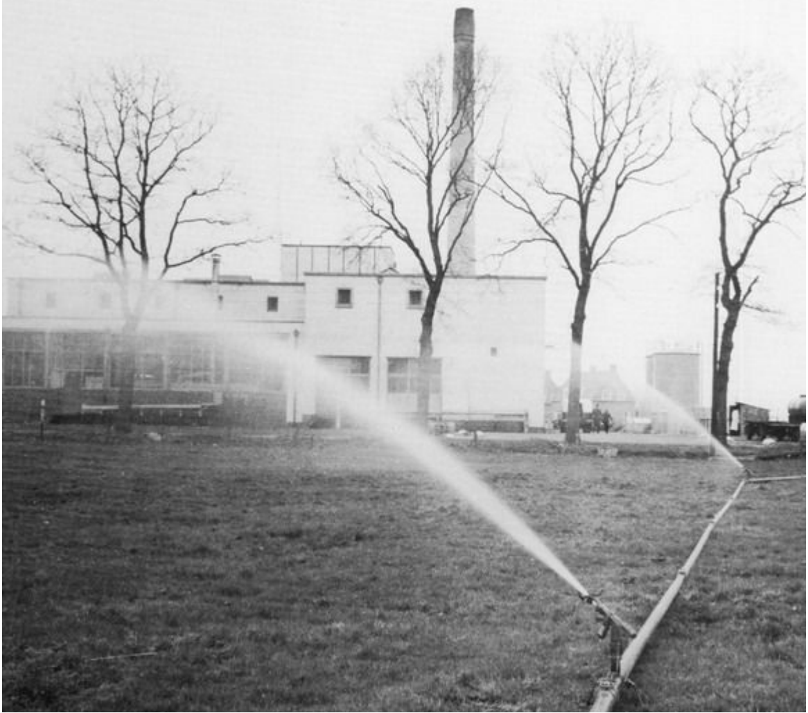
Het afvalwater van de fabriek in Elsloo werd verregend tot dat dit via de riolering kon worden afgevoerd naar de rioolzuiveringsinstallatie in Wolvega.
