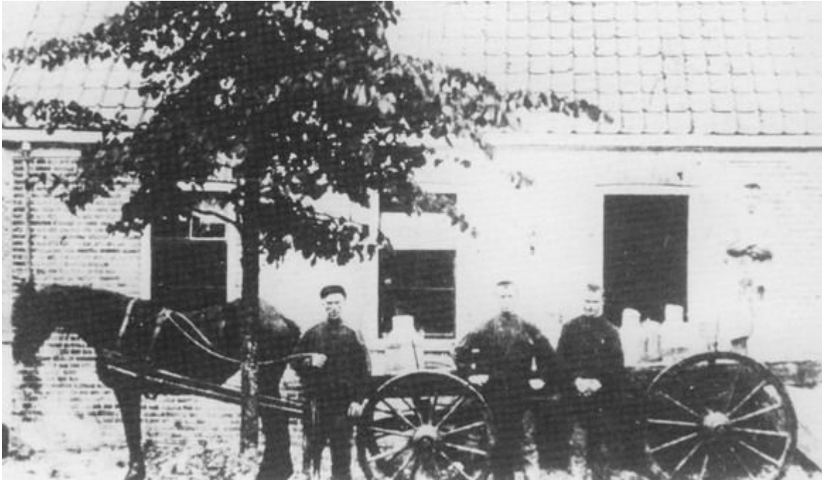
De eerste coöp. zuivelfabriek in Grolloo; het was een handkrachtfabriek, gebouwd in 1894.
