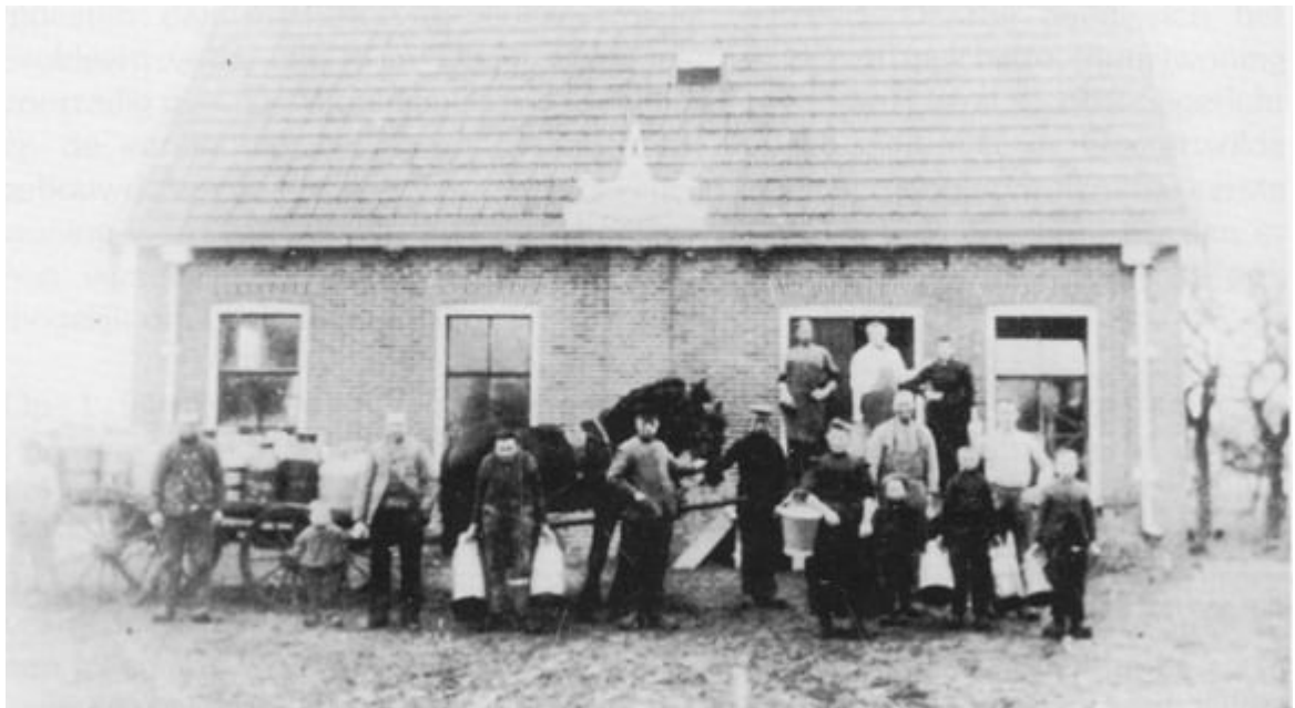
Handkrachtboter fabriek „De Eendracht” in Haulerwijk, opgericht in 1898, die in 1904 overging in de coöperatieve boterfabriek.
