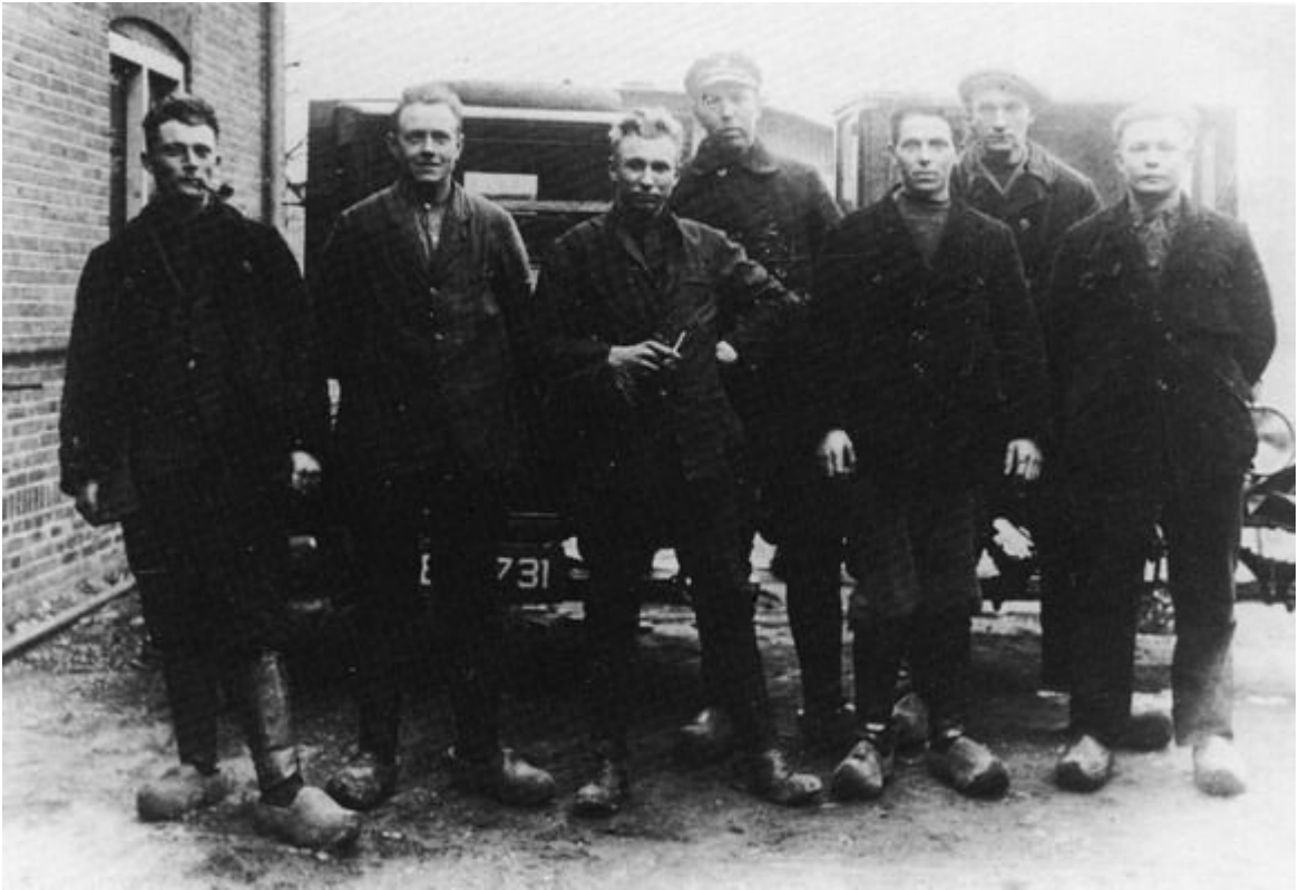
Nog een foto van chauffeurs en busopzetters Chauffeurs droegen veelal leren beenkap- pen, v.l.n.r.: G. Hoonstra, P. Hof, E. Leenstra, H. Sikkes, A. van Veen, S. Russchen en H. Dijkstra.
