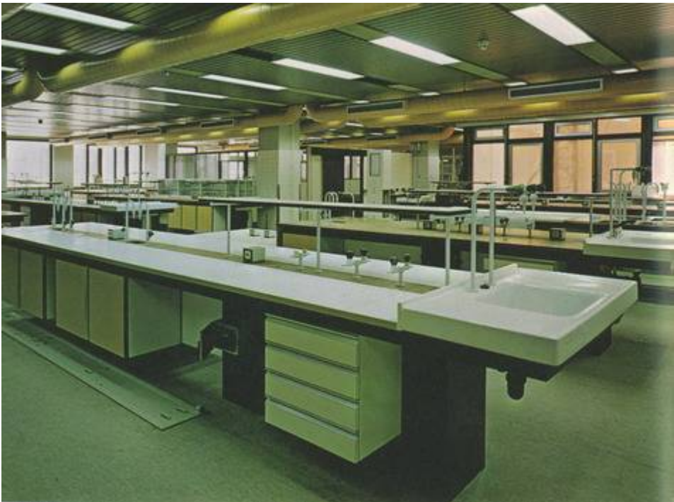
Chemisch laboratorium in aanbouw
