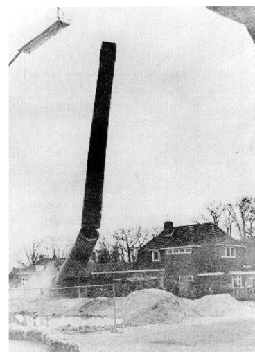
Vallende schoorsteen in Eext
