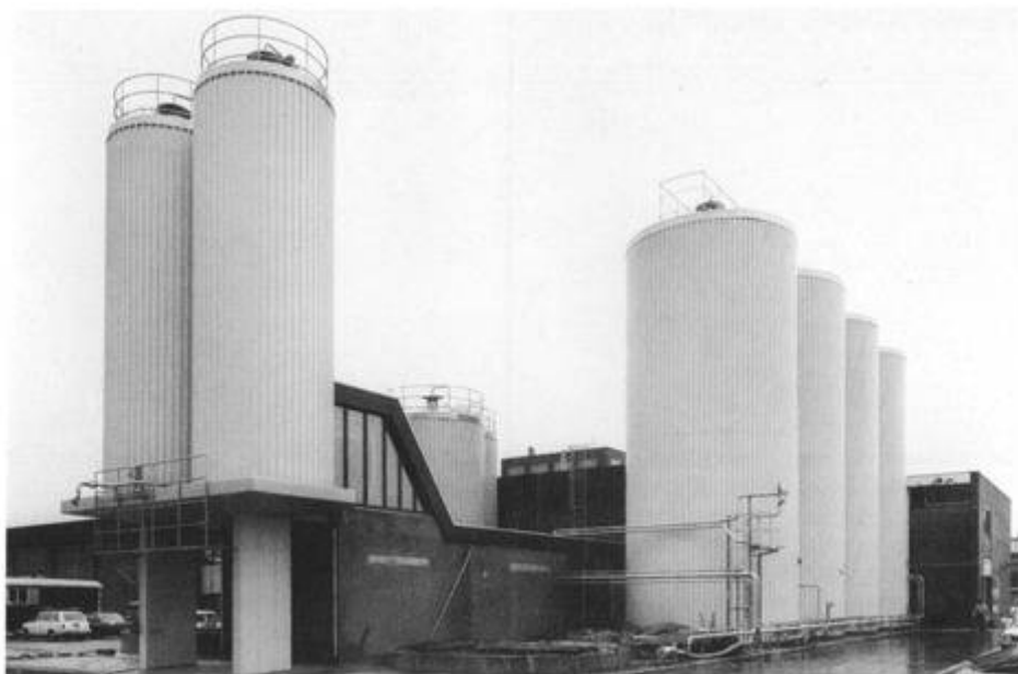
Melk- en roomopslagtanks.
