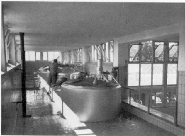
Gedeelte van het tanklokaal van de Coöperatieve Stoom Zuivelfabriek en Maalderij „Wouw” te Wouw 1953 (1)
