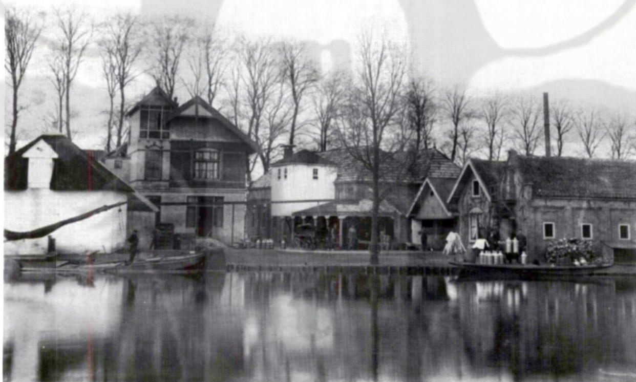
Afb. 4. De zuivelfabriek Insulinde omstreeks 1900. Links het ijspakhuis; rechts daarvan het kantoor. Achter de boom aan de Vechtoever de verhoogde vloer waar de met paardewagens aangevoerde melkbussen konden worden afgeladen; rechts worden melkbussen aangevoerd per boerenschouw. Daarachter een droogrek, waarop doeken hangen die gebruikt werden bij de kaasfabricage. De hoge fabrieksschoorsteen aan de oever van de Vecht is er nog niet.
