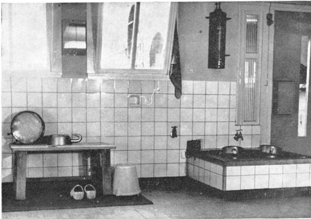
Koelbak, ondergebracht in een kaasbereidplaats; werkbankje en rubber mat; twee waterkranen!
