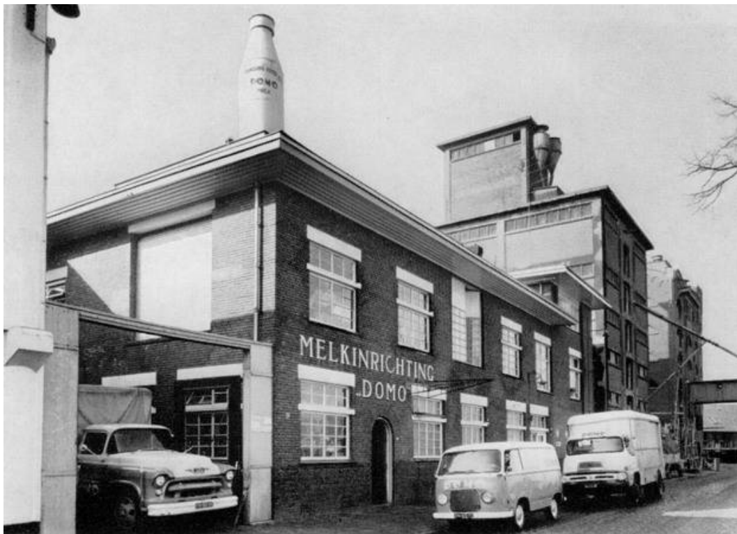
De DOMO-melkinrichting aan de Eendrachtskade te Groningen
