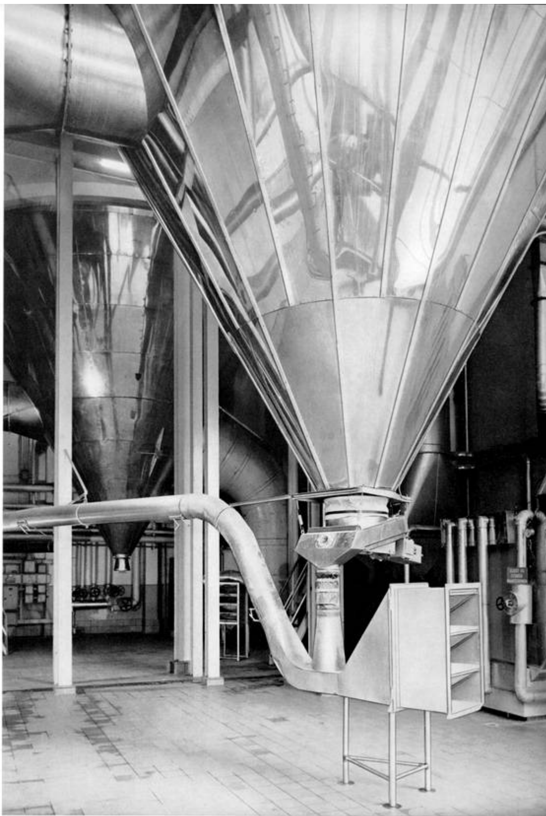
Afvoer van de uit de verstuvingsstoren opgevangen melkpoeder
