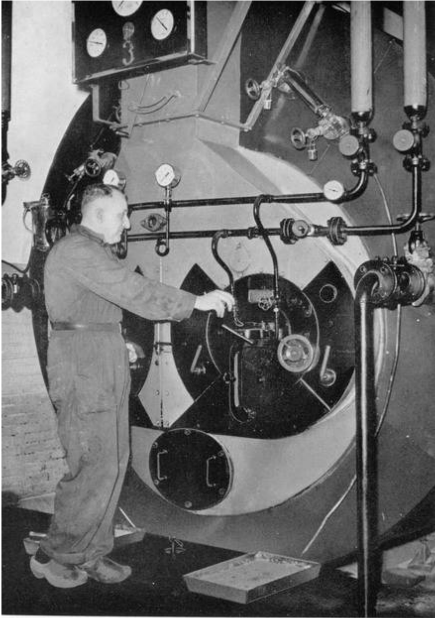
Moderne vlampijpketel met oliestookinrichting 11 atm. druk en 150 m 2 verwarmd oppervlak
