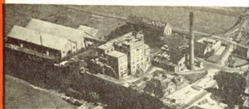
3. Fabriek te Scharsterbrug
