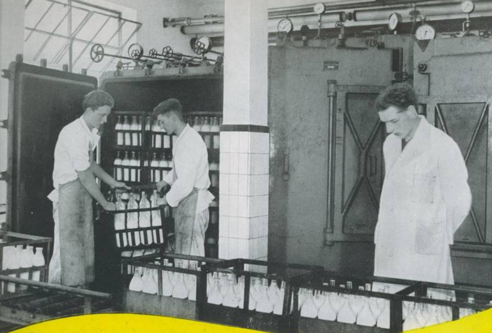
De steriliseerkasten worden geledigd en de flesschen per transportband weggevoerd. Links: nieuwe aanvoer, welke op het verduurzamen in de kasten wacht.
