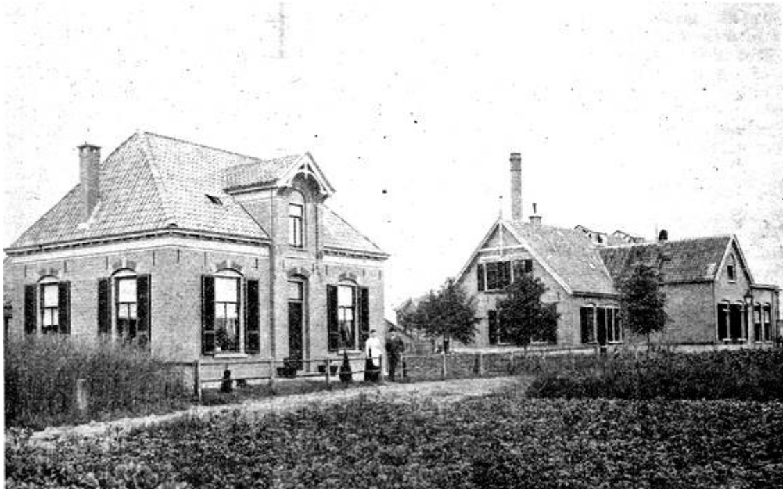
Fabriek met directeurswoning na de verbouwing van 1901
