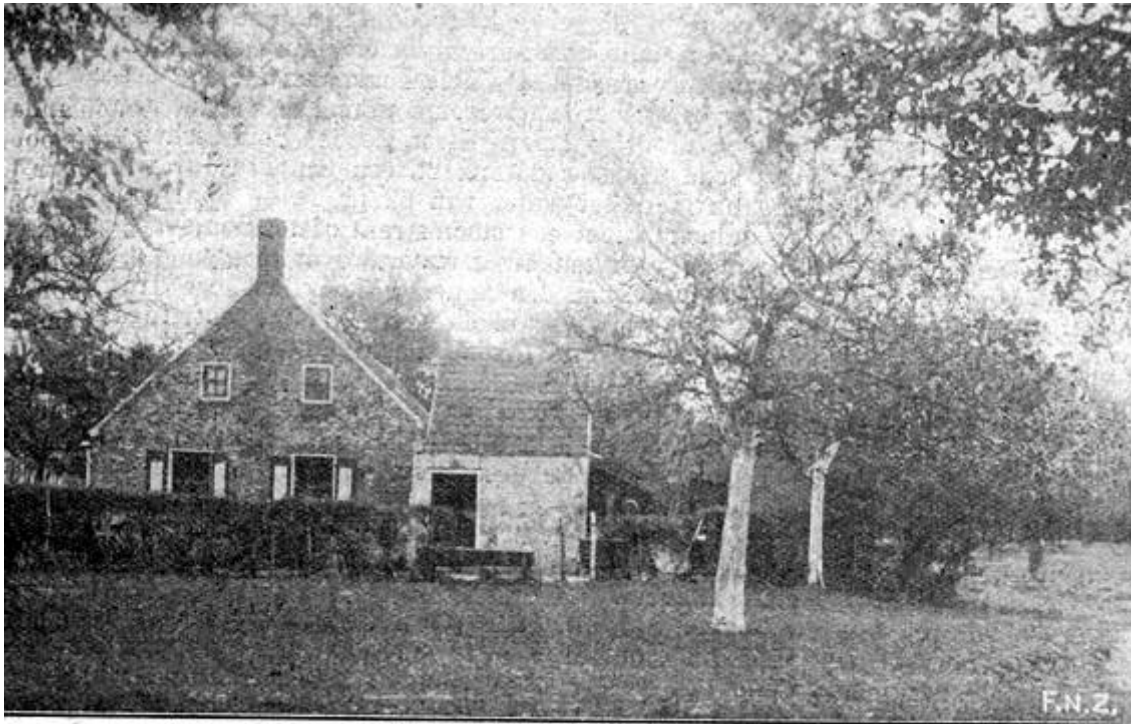
Het 33 jaar in gebruik zijnde gebouwtje der coöperatieve boterfabriek te Wemeldinge.
