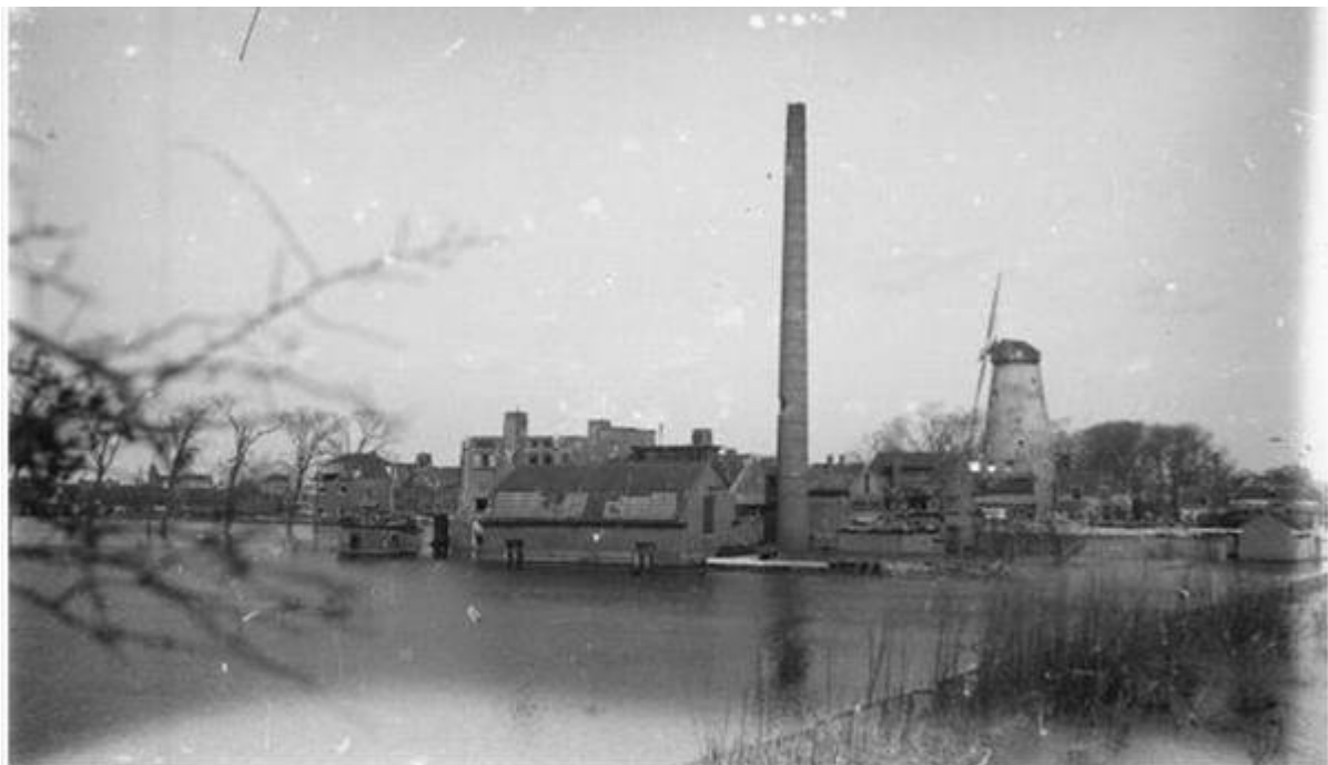
De Coöperatieve Zuivelfabriek en Melkinrichting Walcheren aan de Poelendaelesingel te Middelburg, met rechts de molen De Hoop, onder water.
